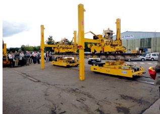
Echange de tronçon de voie
