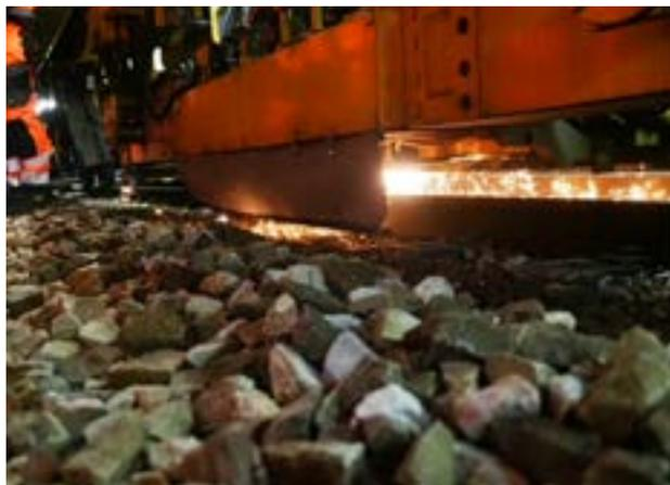
Soudure électrique de deux rails neufs (étincelage). La réalisation des deux soudures est réalisée en 25 minutes.
