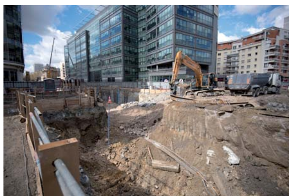
Les travaux de la station Clichy Saint-Ouen au printemps 2016
