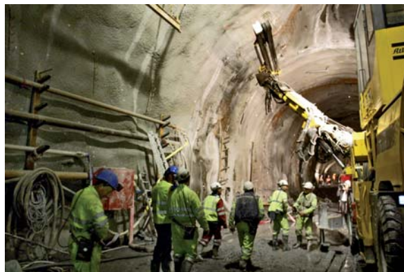
Travaux préparatoires dans le tunnel
