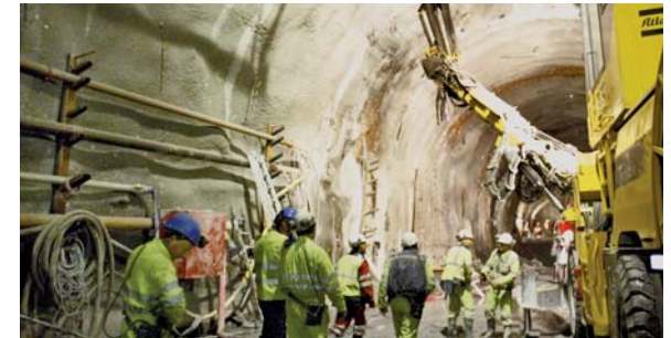
Travaux préparatoires dans le tunnel
