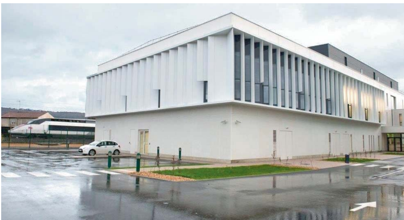
Le bâtiment de la CCR de Pagny sur Moselle
