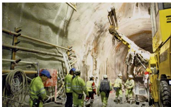
Travaux préparatoires dans le tunnel
