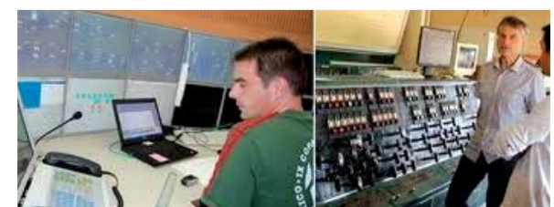
Le poste de commande centralisée
