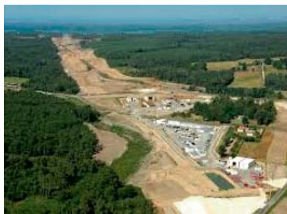
Un chantier de la LGV SEA Tours-Bordeaux
