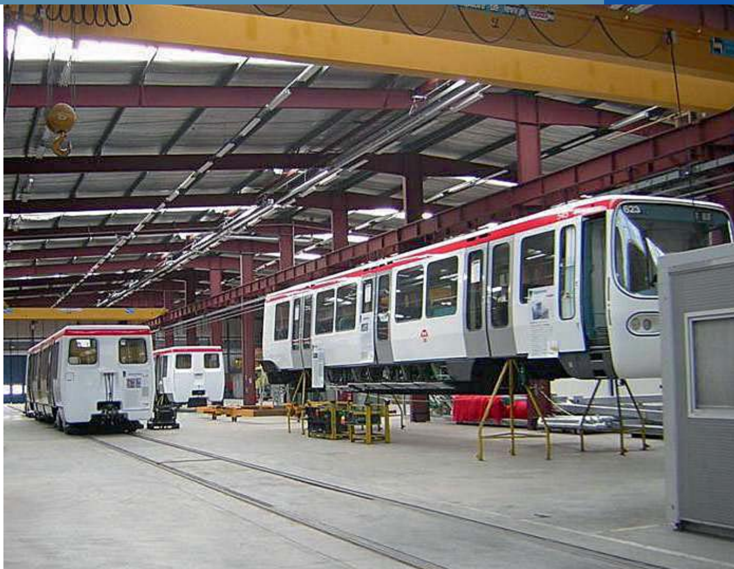
Le dépôt-atelier de La Poudrette
